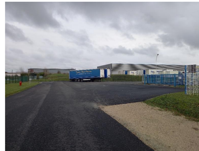
Vue 2 Vue de la zone d'attente depuis la rue des Germines
